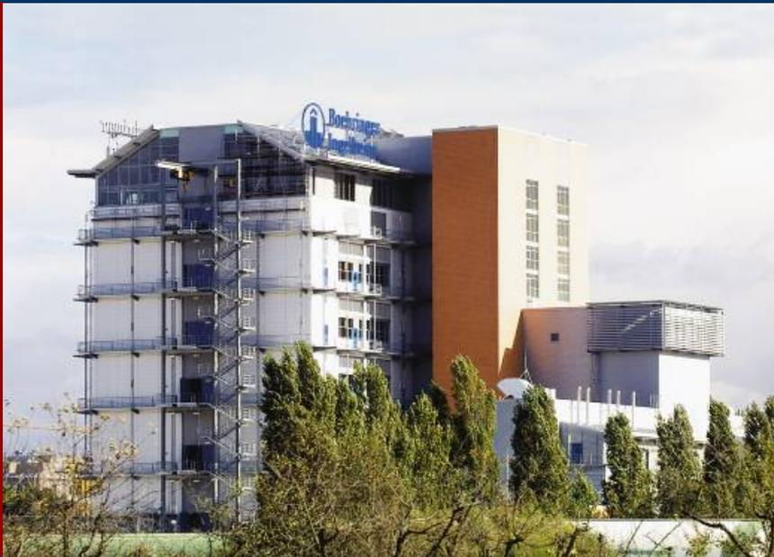
In sechs **Produktionstrakten** werden z. Zt. in dem 50 m hohen Gebäude ca. 15 Wirkstoffe in über 50 Produktionsstufen hergestellt. Der Transport der Substanzen erfolgt ohne Pumpen über Schwerkraft. Eine schnelle Reinigung sorgt für zügigen Produktwechsel. Rund 180 Millionen Euro wurden hier investiert.
